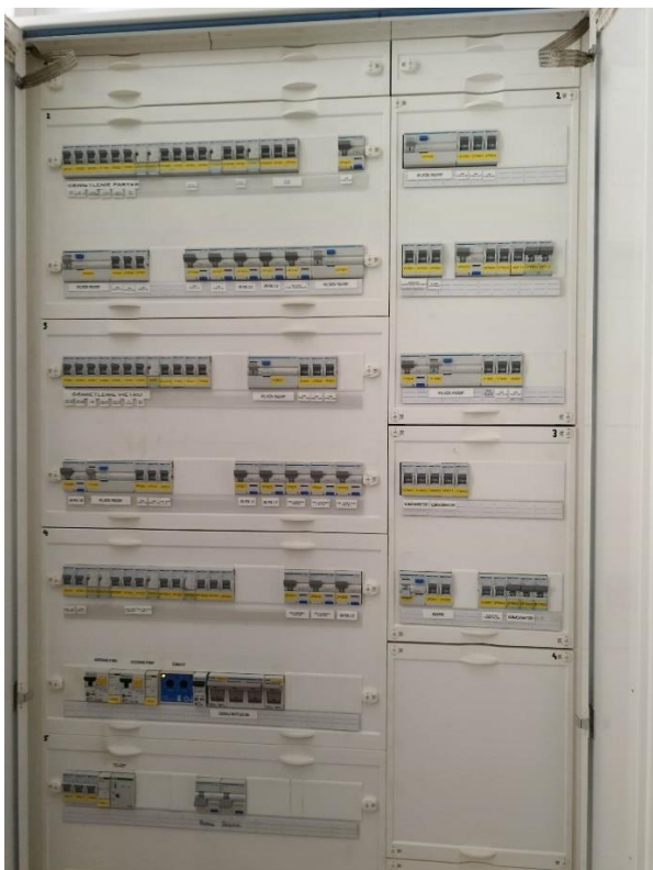
Figura 7 Rozdzielnia elektryczna zlokalizowana w pomieszczeniu technicznym
